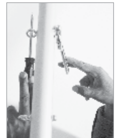
Figura 9: Usar dos dedos para apretar los tornillos.
