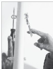
图9: 用两根手指紧固螺栓
