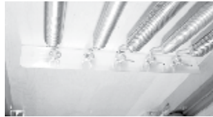
Abb. 3: Federhaken zeigen nach unten
