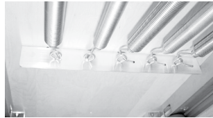
Figura 3: Resortes enganchados hacia abajo
